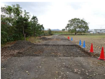
図4 舗装剥ぎ取り後の様子 (手前：無対策、奥：対策)
