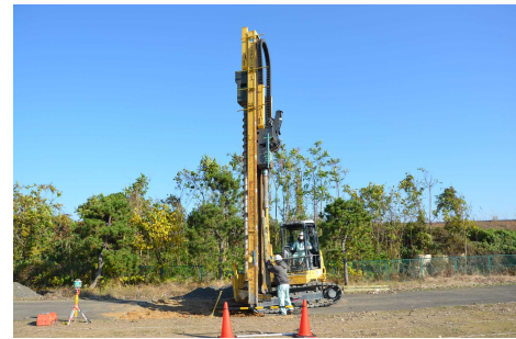
図9 丸太打設の様子
