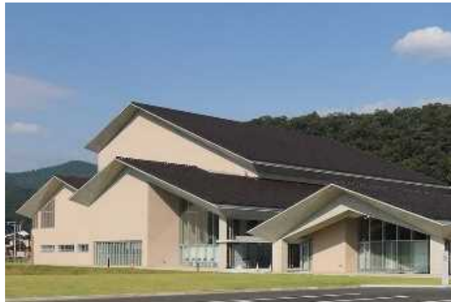
■ 完成した屋根シルエット
