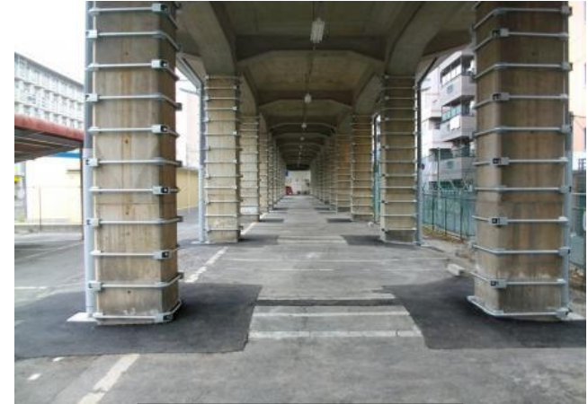
リブバー工法
