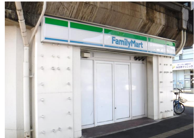
一面耐震補強工法
