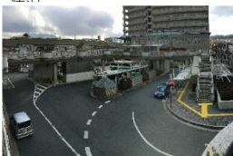
北口駅前広場の状況
