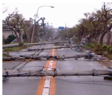
＜電柱の倒壊による道路閉塞＞
