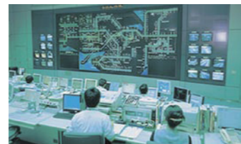
道路管制センター
