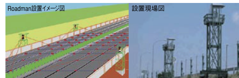
ロードマンの設置状況
