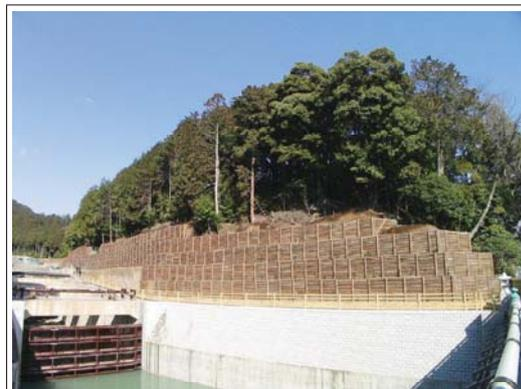
琵琶湖の南側に位置する石山寺で行なわれた大津放水路事業。石山寺の景観保全のため、施工されたコンクリート吹付けをはぎ取って施工したケース。 [滋賀県大津市 2005年施工]
