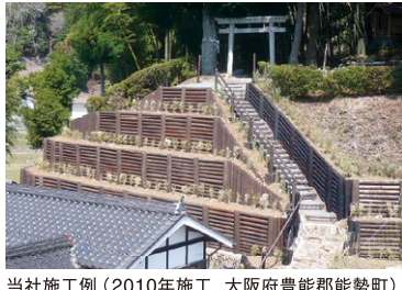
当社施工例 (2010年施工 大阪府豊能郡能勢町)
