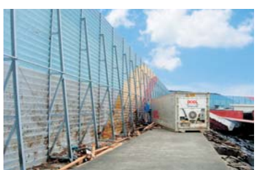
漂流物を捕捉し、堤内地の被害軽減に寄与したと見られる事例
