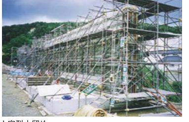
L字型土留め 「山口～下山口工区路下整備その他工事」
