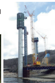
橋脚の施工状況
