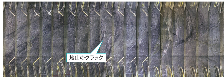
補正済み画像を連続して結合し、展開図をリアルタイムに作成
