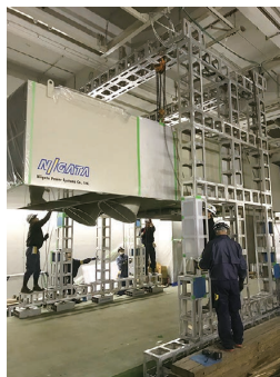
タービン吊り荷重7.5t
