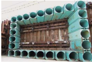
低土被り・切羽掘削のない施工法
