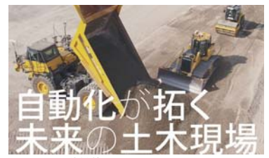
A 4 CSEL ® 稼働状況
