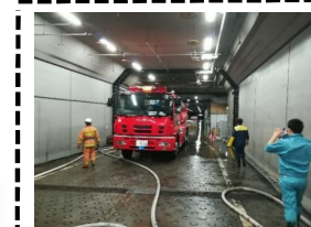
大型ポンプ車等
