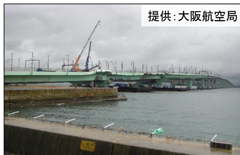
【タンカーが衝突した関空連絡橋の様子】
