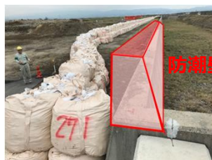
防潮壁の嵩上げ
