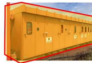
排水ポンプ浸水対策
