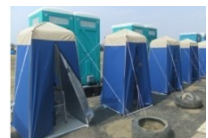
災害時に利用できる防災トイレ（マンホールトイレ）
