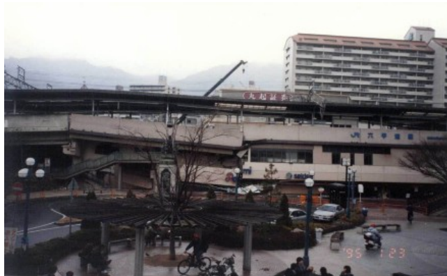
JR六甲道駅舎倒壊(神戸市灘区)
