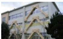
建築物の耐震改修
