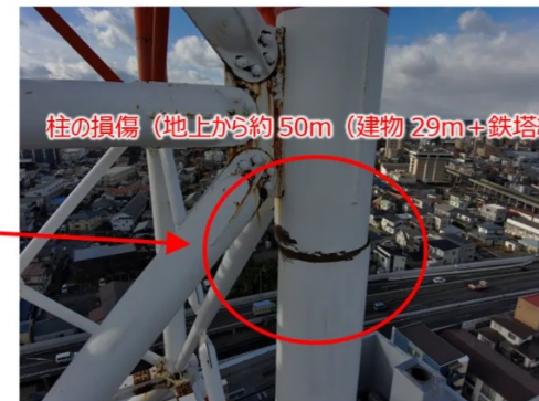
NTT青森八戸ビルに設置された鉄塔の損傷(NTT報道発表資料より)
