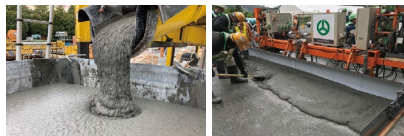
【スティフクリート・専用フィニッシャーによる敷きならし】
